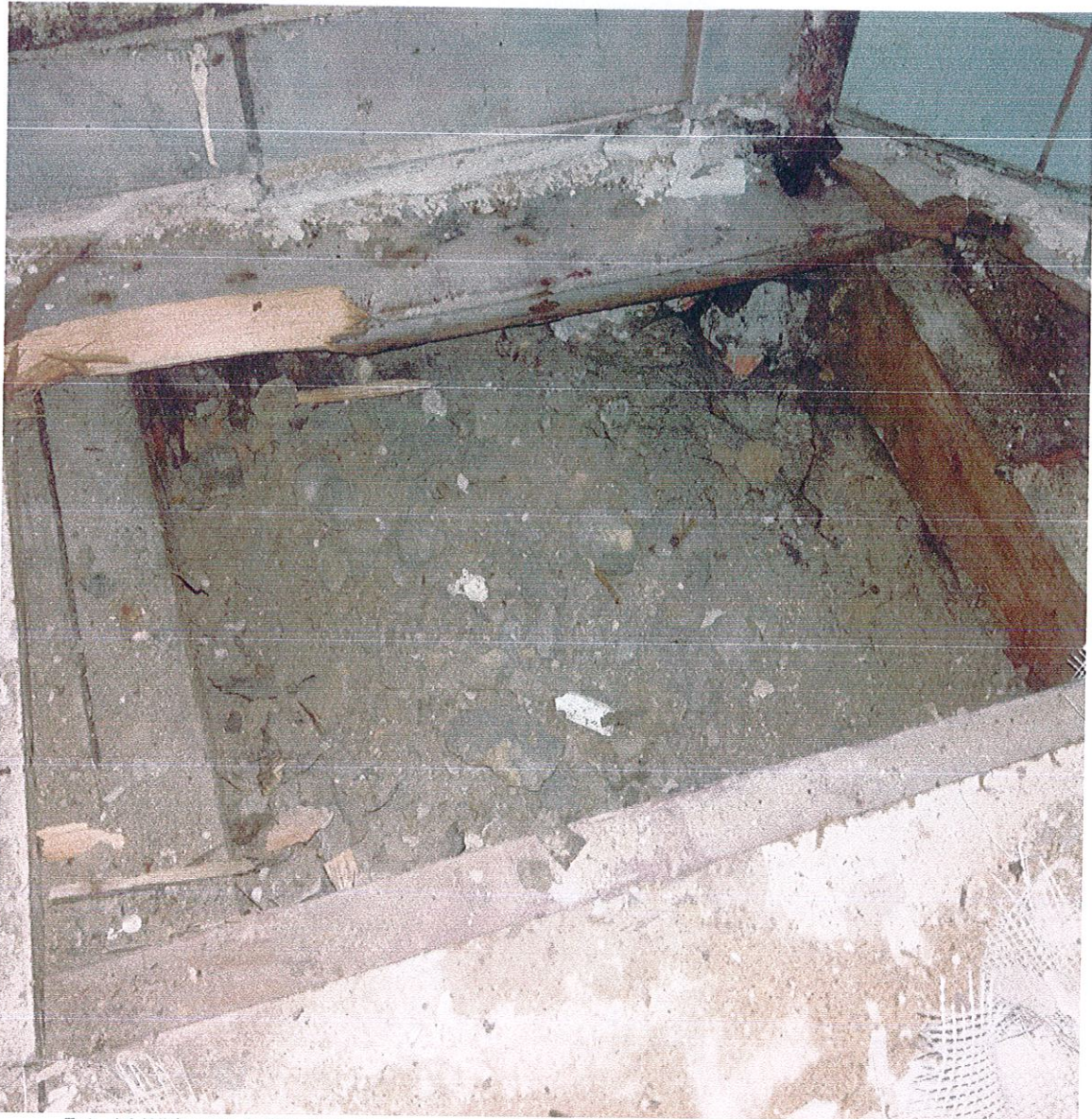
Fot. 14 Widoczne belki stropowe o wymiarach 180x200mm w rozstawie osiowym około 900mm
